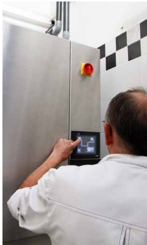
L'unité de déshydratation est dotée d'un tableau de commande tactile qui permet de contrôler sur place et à distance le fonctionnement de tout le système
